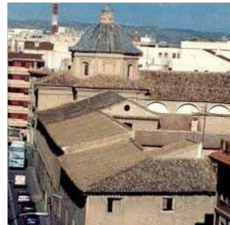
Fachada conventual de los s. XVII y s. XVIII. Reposición de paños de ladrillo yagueado y cajetones en estuco de cal.
