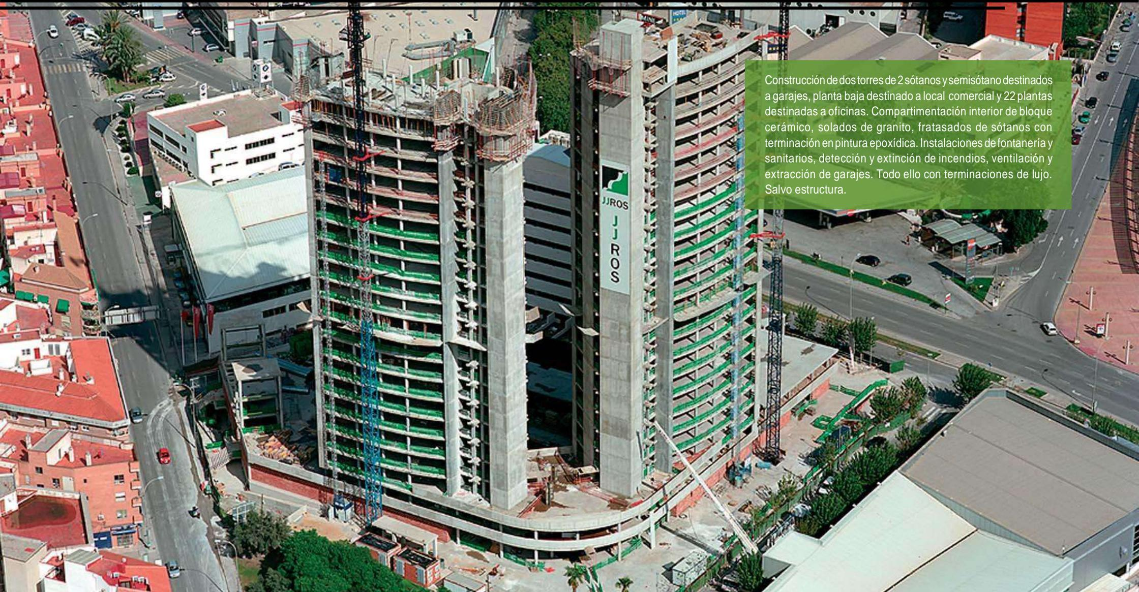
Construcción de dos torres de 2 sótanos y semisótano destinados a garajes, planta baja destinada a local comercial y 22 plantas destinadas a oficinas. Compartimentación interior de bloque cerámico, solados de granito, fratasados de sótanos con terminación en pintura epóxica. Instalaciones de fontanería y sanitarios, detección y extinción de incendios, ventilación y extracción de garajes. Todo ello con terminaciones de lujo. Salvo estructura.
